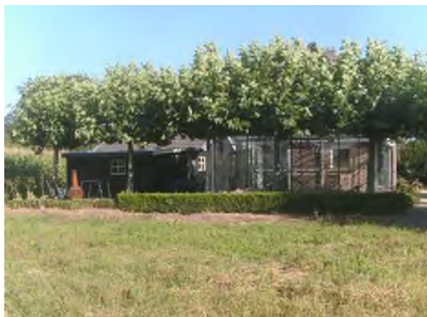
Foto 2: Onderzoekslocatie vanaf zuiden gezien, met links de te slopen schuur en rechts de kas met voorliggende woning/
