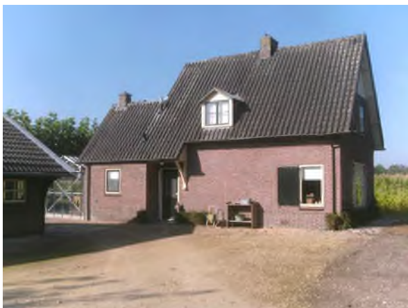
Foto 1: Het te vervangen woonhuis met aanbouw en achterliggende kas/
