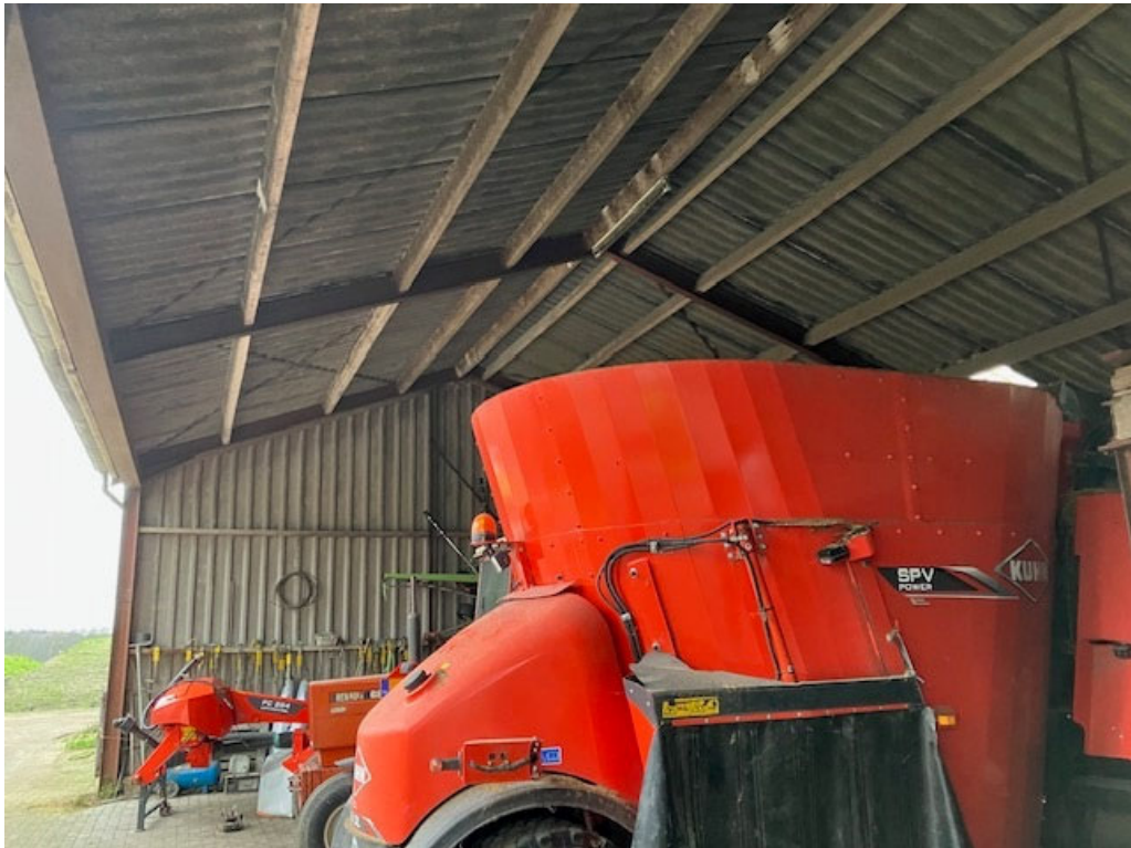
• Afbeelding 14: binnenzijde te slopen veldschuur
