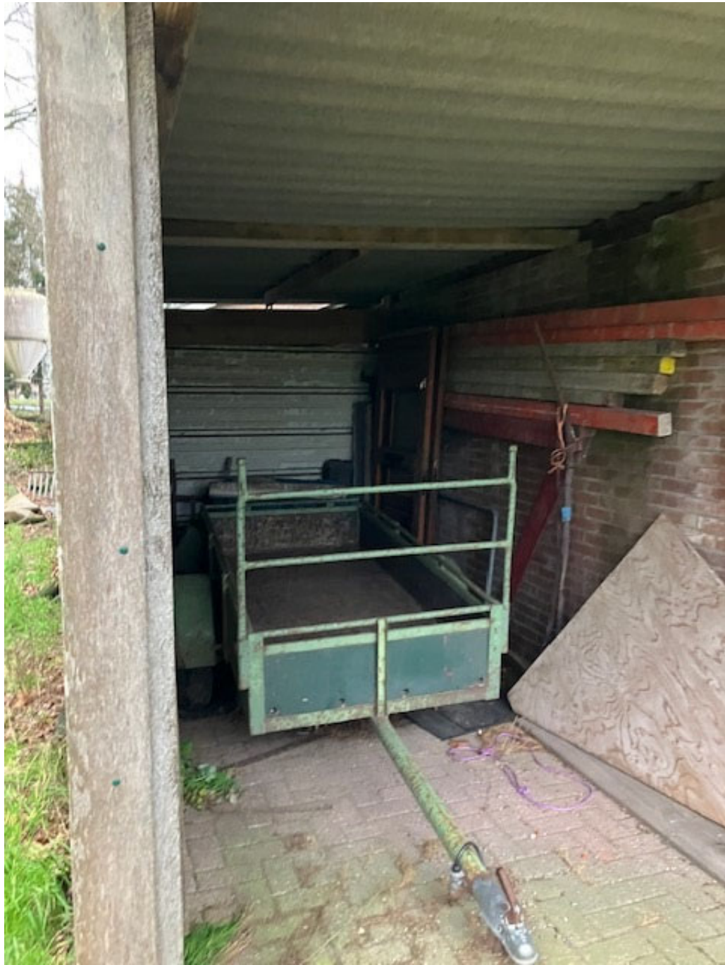
• Afbeelding 28: binnenzijde overkapping van damwand
