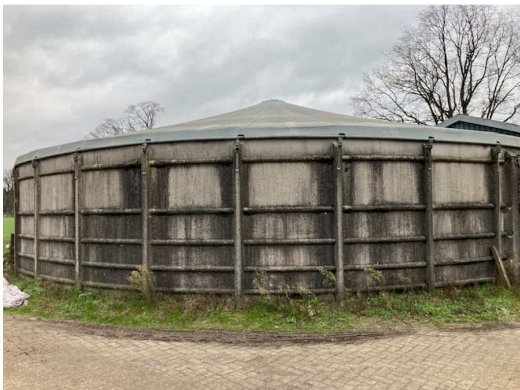
• Afbeelding 19: te verwijderen mestsilos
