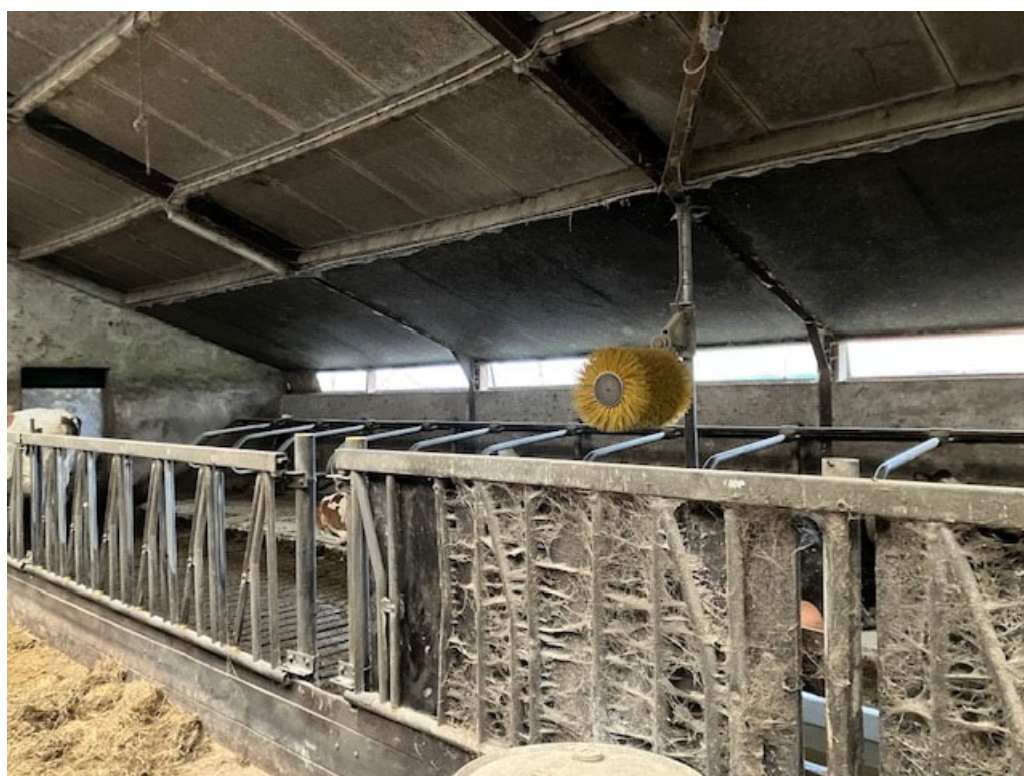
• Afbeelding 25: onderzijde dak te slopen koeienstal
