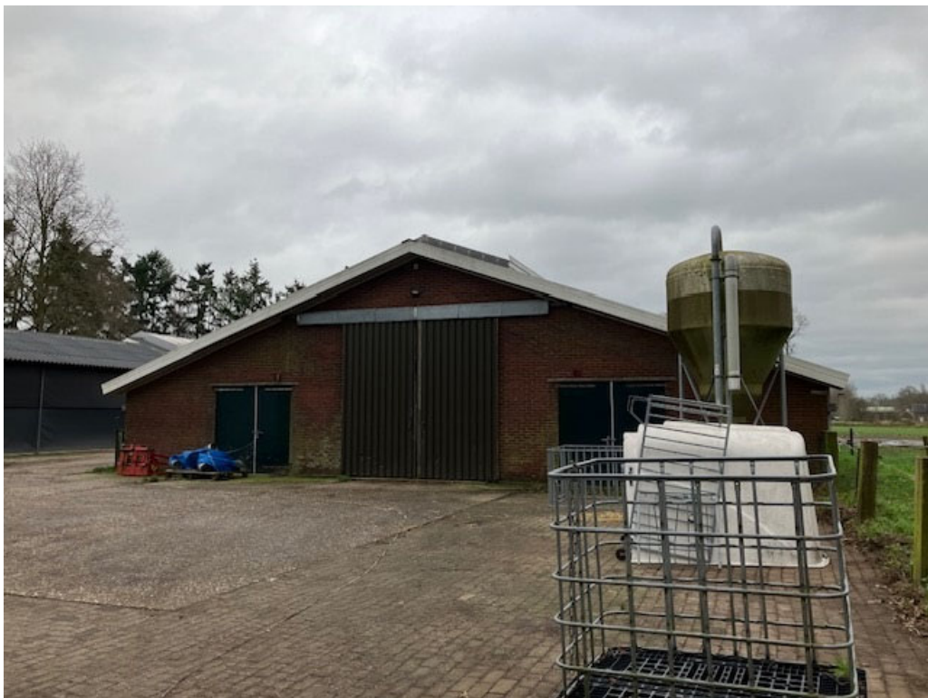
• Afbeelding 21: voorgevel te slopen stal, andere zijde van het bedrijf
