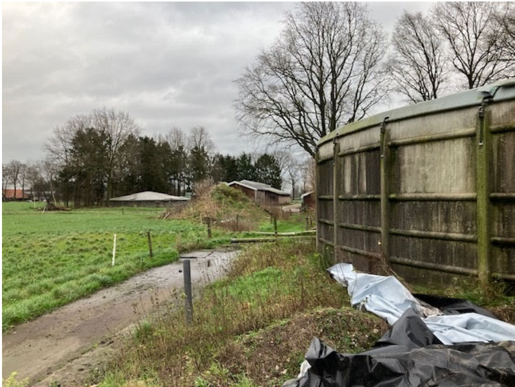
• Afbeelding 20: te verwijderen mestlo met zicht op te slopen stallen en andere silo
