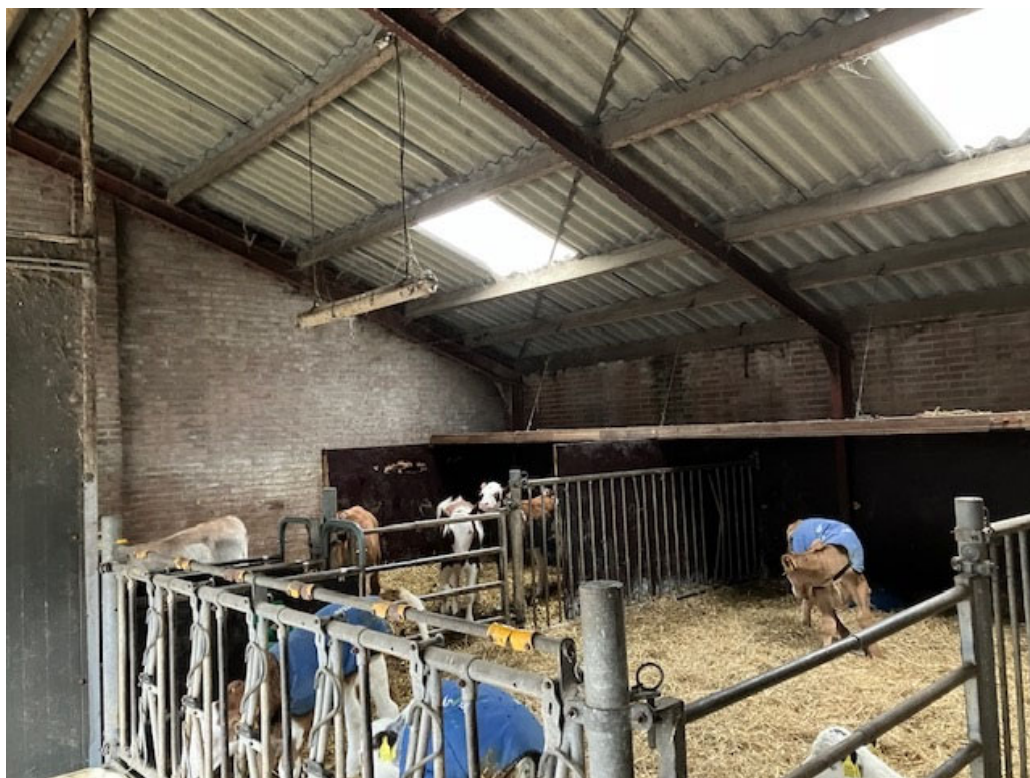
• Afbeelding 39: binnenzijde jongveestal, dak ongeïsoleerd
