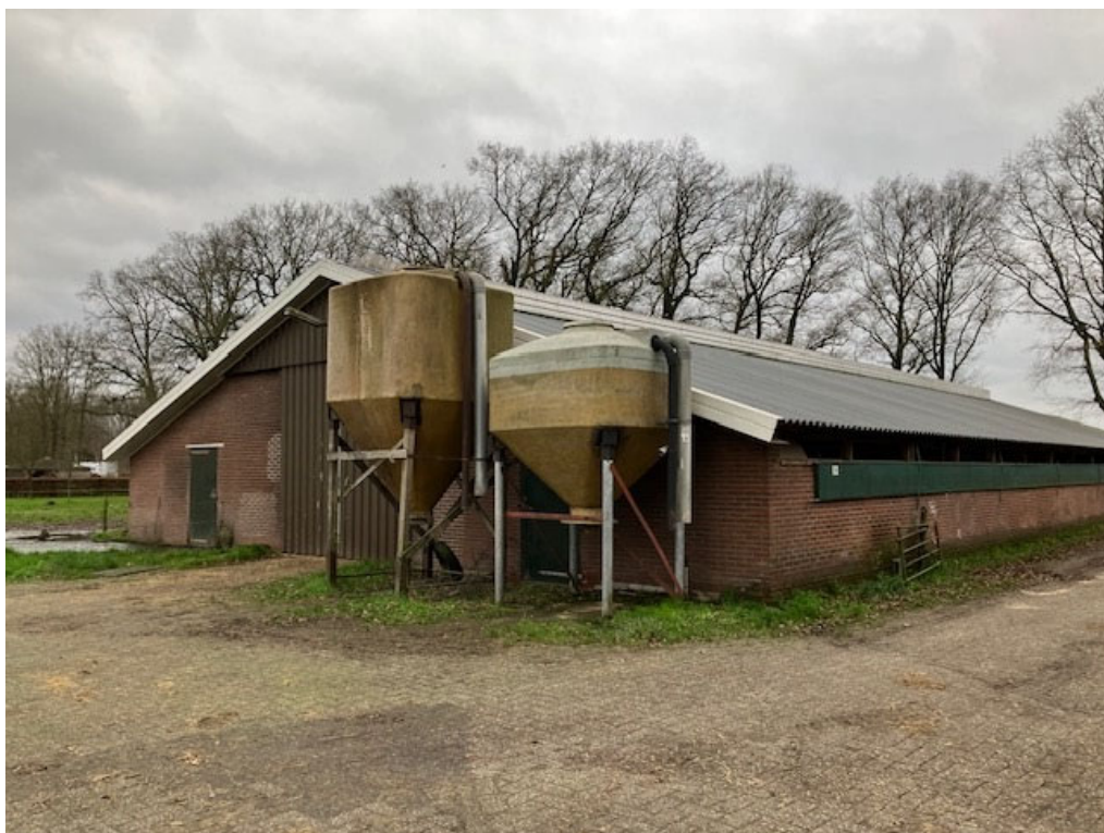
• Afbeelding 37: achtergevel te slopen koeienstal
