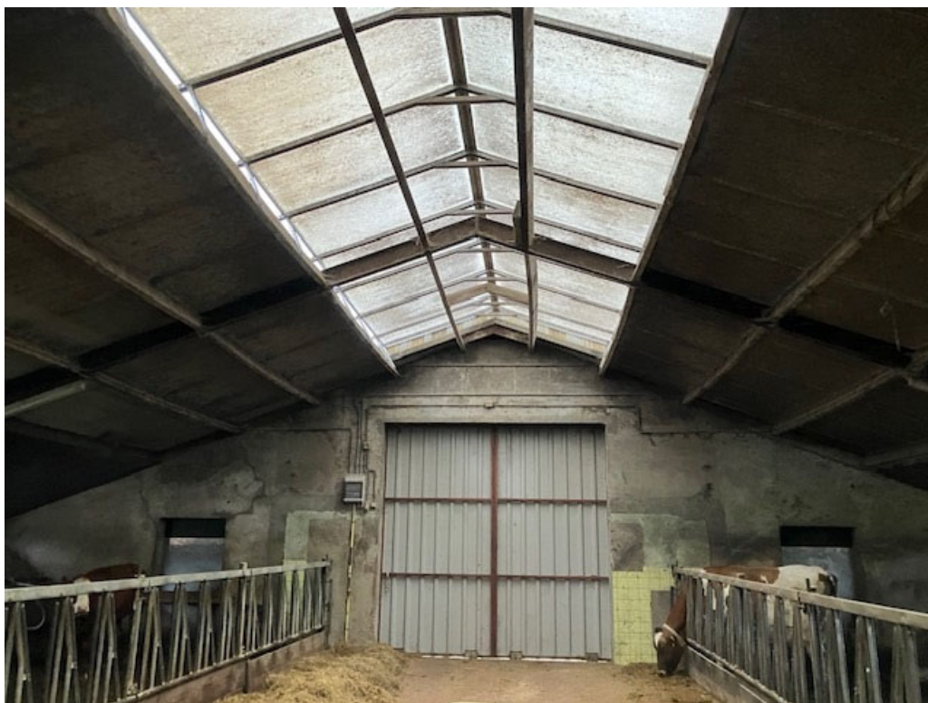
• Afbeelding 24: binnenzijde te slopen koeienstal
