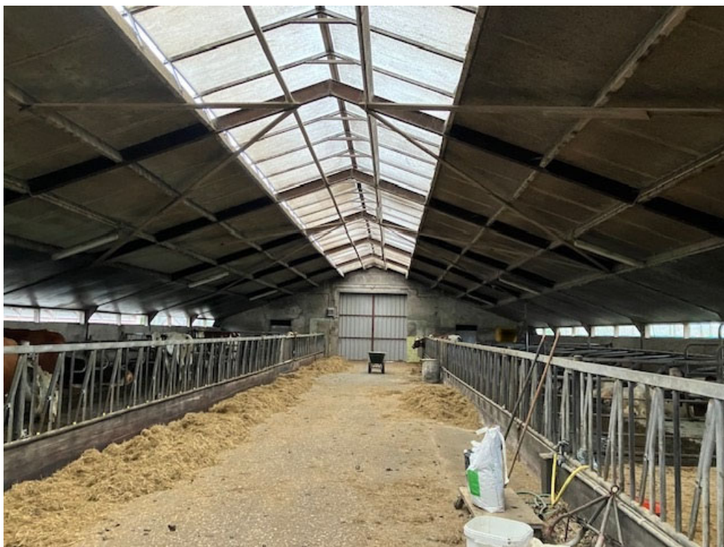
• Afbeelding 23: binnenzijde te slopen koeienstal
