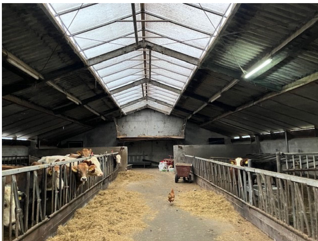
• Afbeelding 34: binnenzijde droge koeienstal, dakplaten ongeïsoleerd
