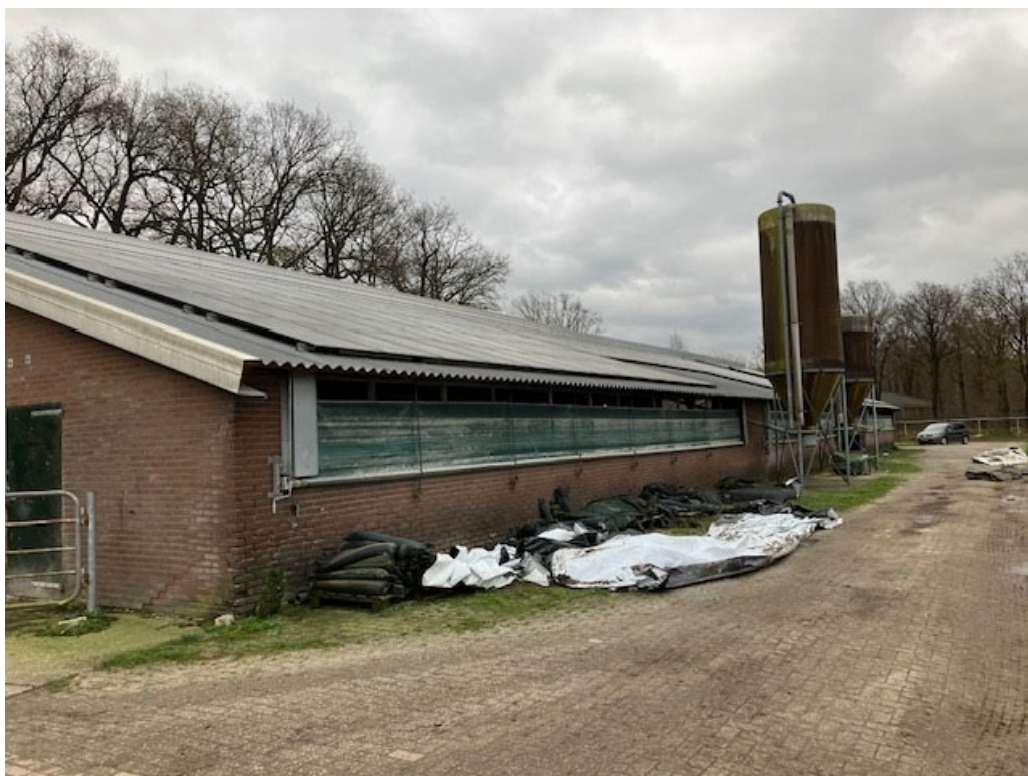
• Afbeelding 16: Zijgevel te slopen koeienstal
