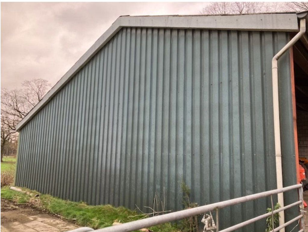
• Afbeelding 15: achterzijde te slopen veldschuur
