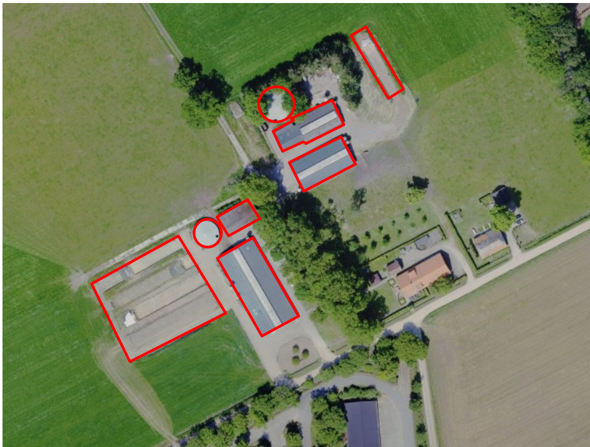
Bestaande situatie met in rood de te slopen bebouwing en voorzieningen
