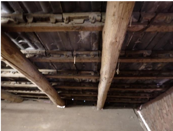
Foto 9: links, houten gebint van bezaagde balken en ronde ruiters.
