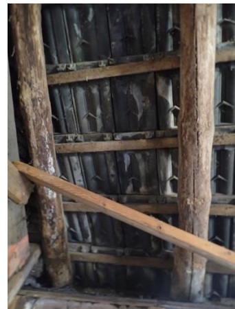
Foto 12: rechts, dakpannen op de boerderij, vanaf binnen gezien. Geen holle ruimtes onder dakpannen.
