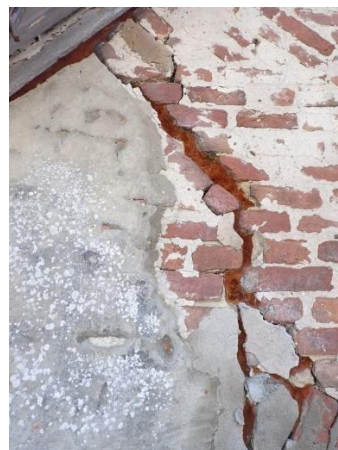
Foto 4: rechts, scheur in de bakstenen muur. Deze is in het verleden dicht gemaakt.
