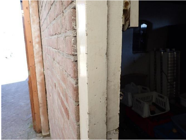
Foto 13: links, massieven muur van 1 steen dik.
