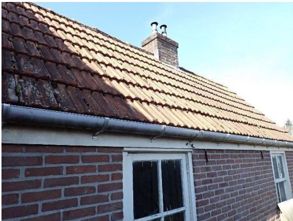
Foto 17: links, gebouw met pannen dak.
