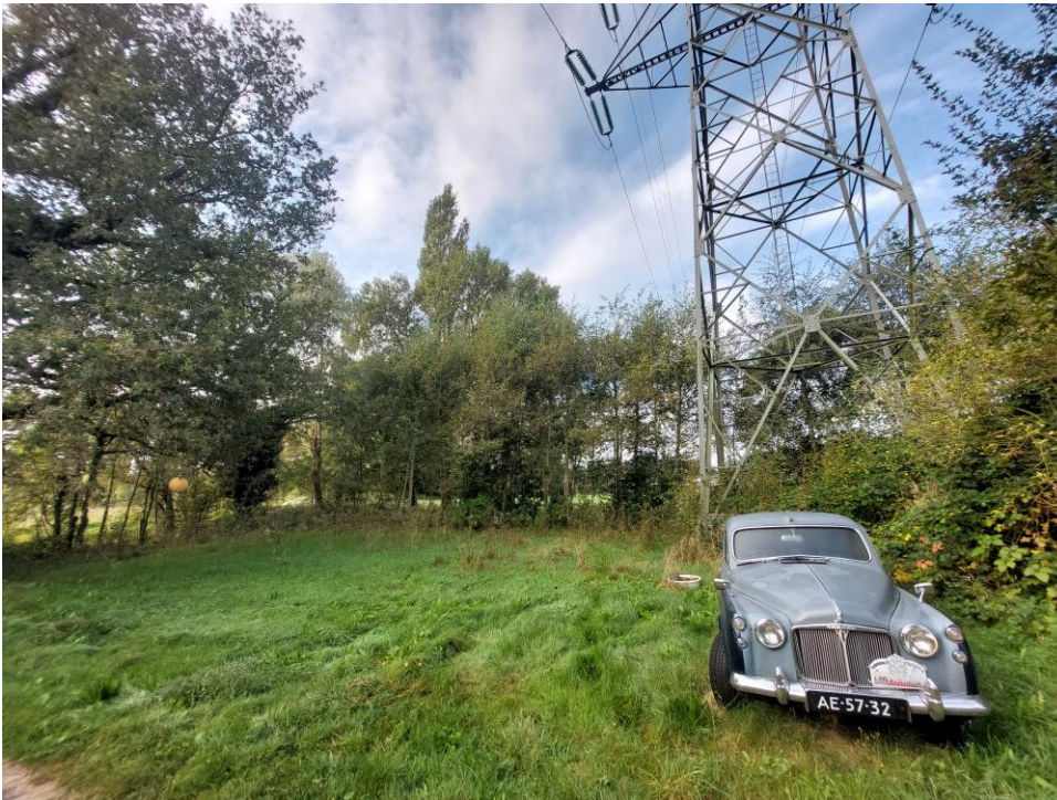
Figuur 3; Mast 21 bij IJsseldijk 82
