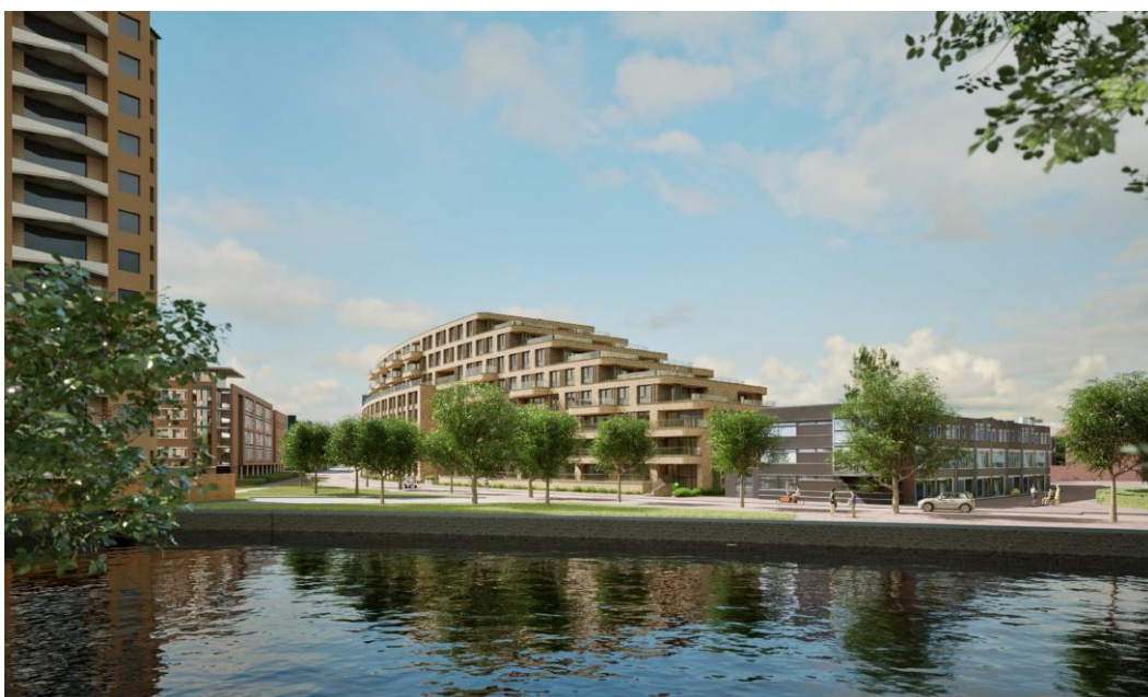
f 4.4 Ligging beoogd gebouw ten opzichte van bestaande bebouwing rechterzijde.
