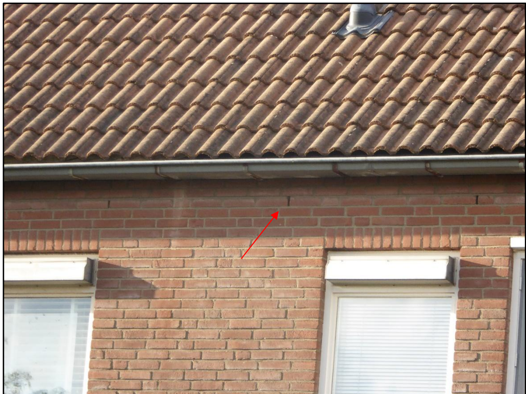
Bebouwing aan noordzijde plangebied met spleten toegang tot de spouw (rode pijl).
