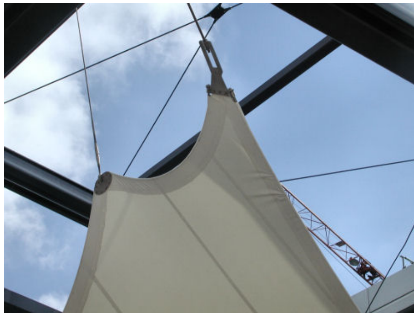
gespannen membraanconstructie tussen stalen frame
