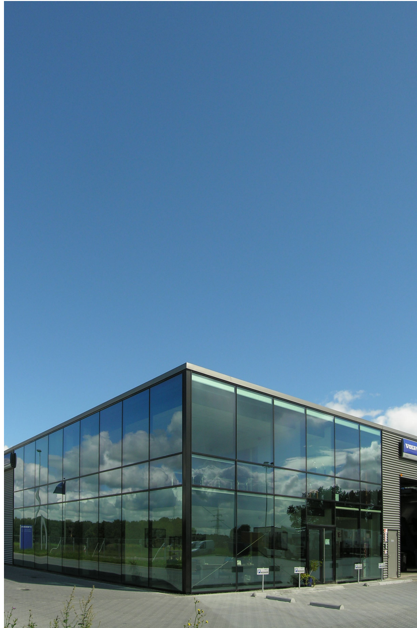
zwarte vliesgevel v.v. zonwerende beglazing
