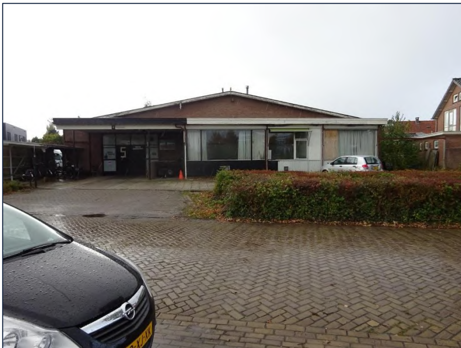
P00890_FO_05 : Beeld van de overzijde van het braakliggend terrein. De panden die hier staan zijn allen in de naoorlogse periode ontstaan (1960 en 1969). Uit de naoorlogse beeldanalyse is gebleken dat dit deel van het plangebied in de periode na 145 veelvuldig is veranderd qua gebruikersdoel en bijbehorende opstallen.
