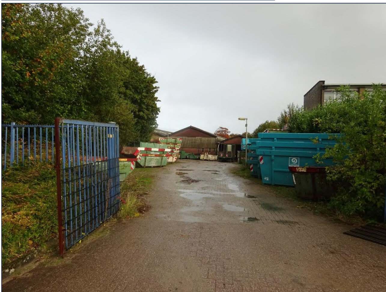
P00890_FO_02 : Beeld genomen vanaf de naoorlogse Condorweg op het pand op nummer 12. Te zien zijn verder begroeiingen, hekwerk en verhardingen, welke tevens in de naoorlogse periode zijn aangelegd.
