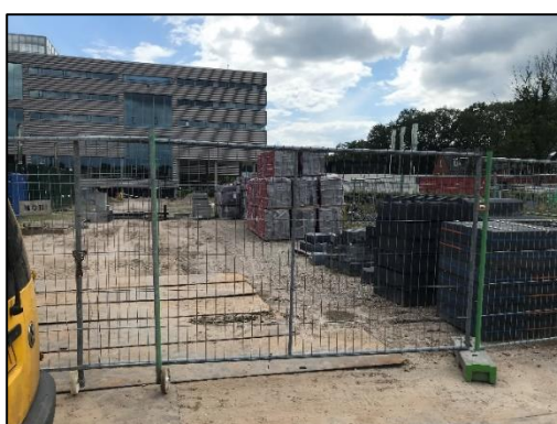
Foto 4. Werkterrein ten westen van het plangebied, gezien vanuit het noorden
