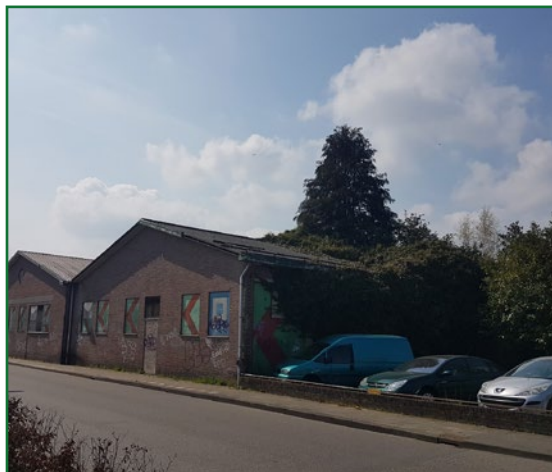
Afb. 2.5: Parkeerterrein nabij kruising met Asselsestraat. Het te slopen pand is deels overwoekerd door klimop waarin vogels kunnen nestelen.
