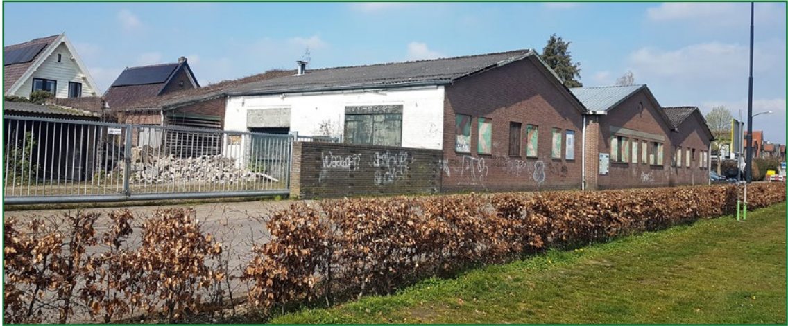
Afb. 2.1: De te slopen loodsen gezien vanaf de overkant van de Prinses Beatrixlaan. Links (achter het hek) is nog net een deel van de overkapping zichtbaar.
