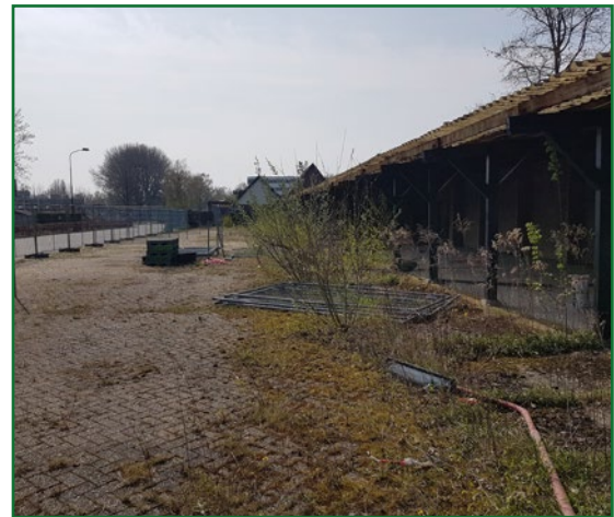
Afb. 2.4: Zuidelijk deel terrein met links de Prinses Beatrixlaan en rechts de overkapping.
