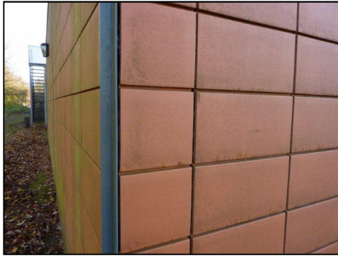
Figuur 5: Onder de gevelplaten is geschikte ruimte aanwezig voor vleermuizen.
