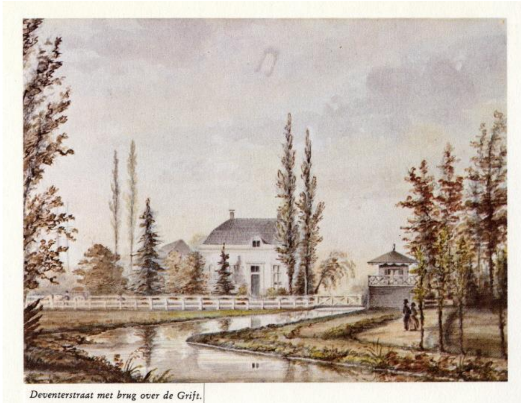
Afbeelding 5 De Grift met brug gezien in zuidoostelijke richting. Het gebouw in het midden is Huize Beekzicht. Foto van een tekening van Arie Lieman, getekend omstreeks 1850. Bron: CODA Apeldoorn, arch.nr. GA-006899.
