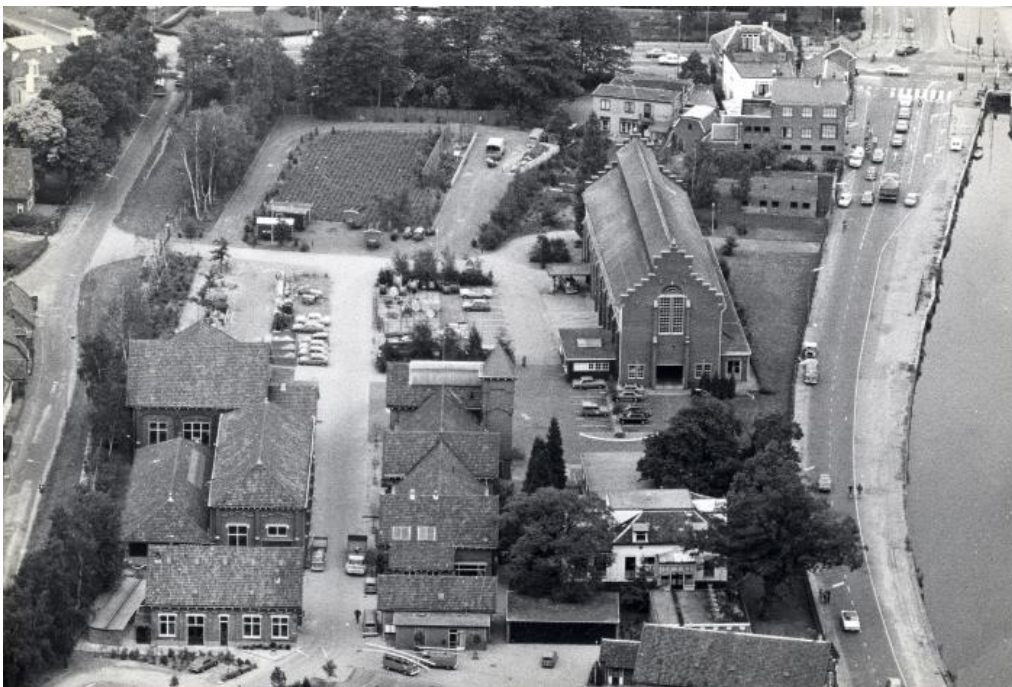
Afbeelding 8 Overzichtsfoto van het complex van de Gasfabriek in noordelijke richting. Rechts Kanaal Noord met boven de kruising met de Deventerstraat en de Vlijtseweg. Links de Griftstraat overgaand in Beurtvaartstraat; foto 1970-76. Bron: CODA Apeldoorn, arch.nr. GA-016326.
