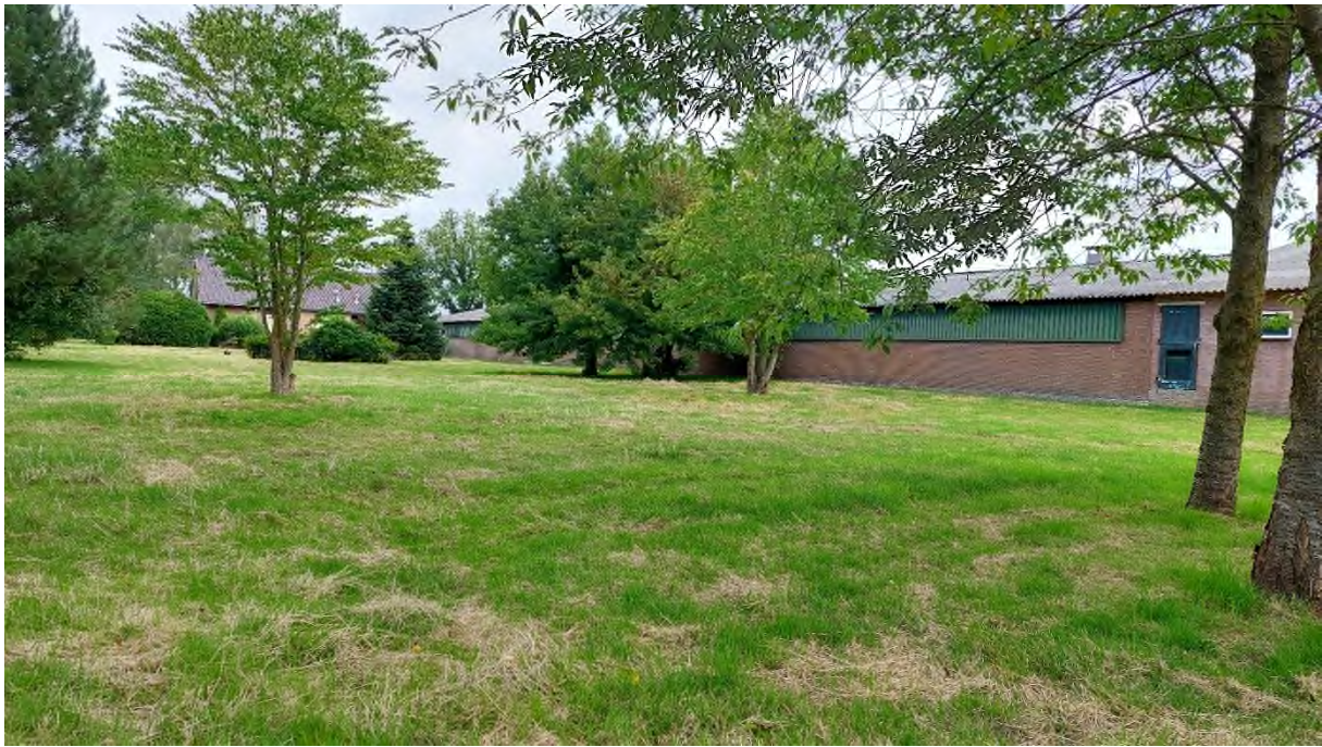
Figuur 14: Westzijde van de varkensstal met linksachter het woonhuis, gefotografeerd richting het noorden (bron: KSP Archeologie).
