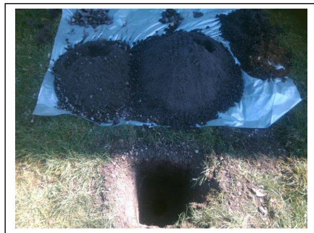
Foto: Inspectiegat B11
