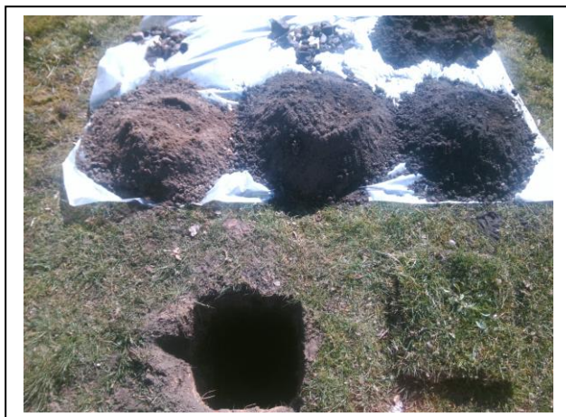
Foto: Inspectiegat B10
