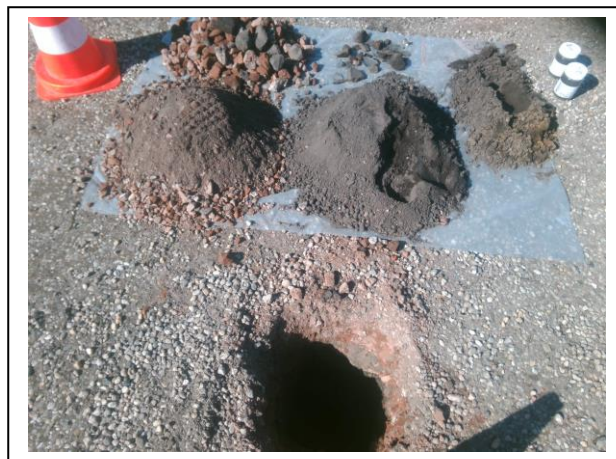
Foto: Inspectiegat B05
