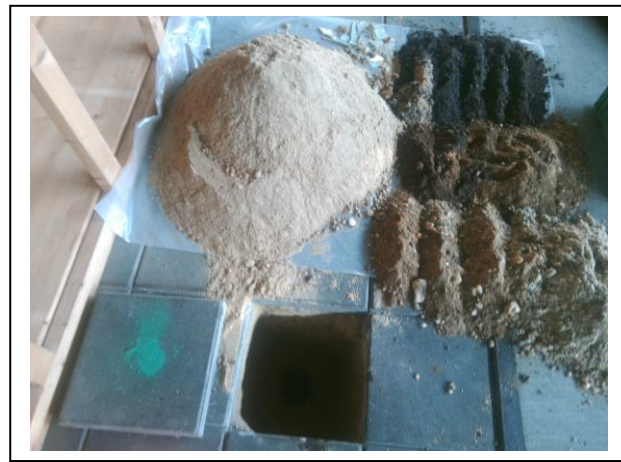
Foto: Inspectiegat B13
