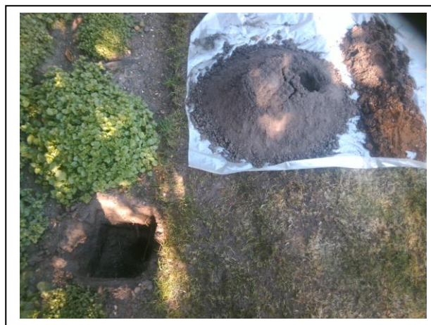
Foto: Inspectiegat B03
