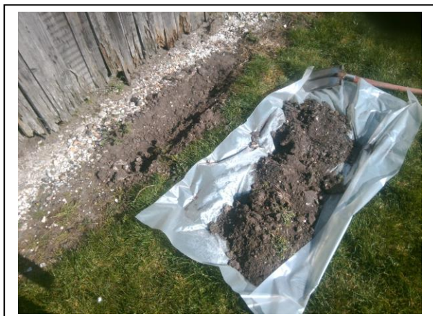
Foto: Inspectiesleuf A01
