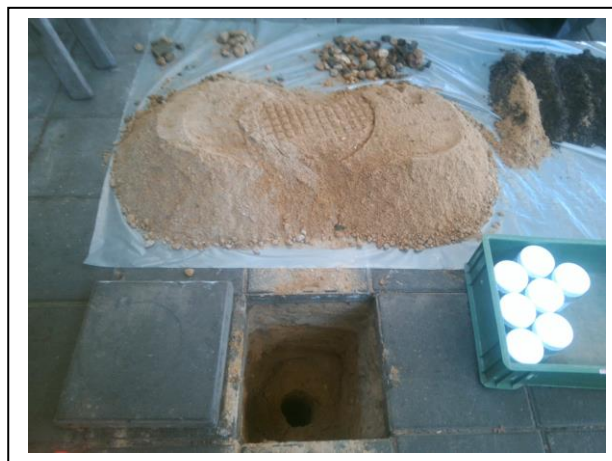
Foto: Inspectiegat B02
