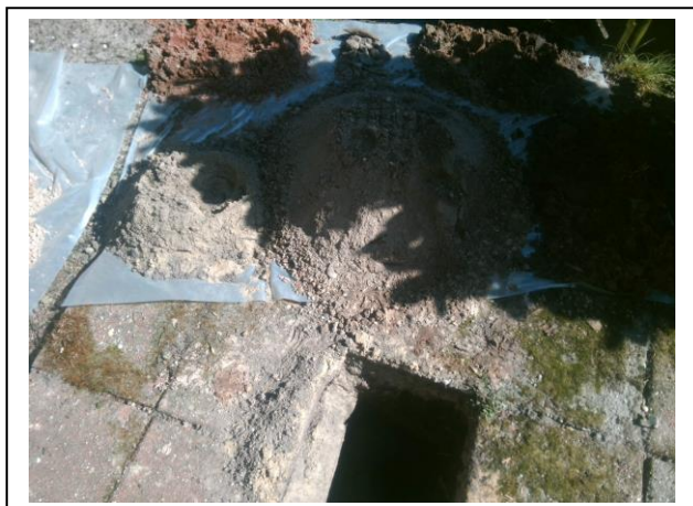
Foto: Inspectiegat B04
