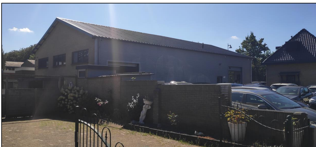
Ramen van werkplaats aan de noordzijde van het bedrijfsgebouw
