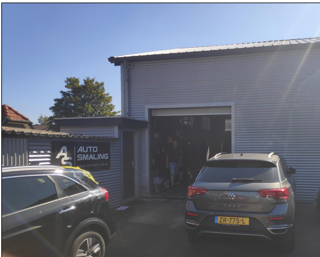
Overheaddeur (westzijde) van het bedrijfsgebouw
