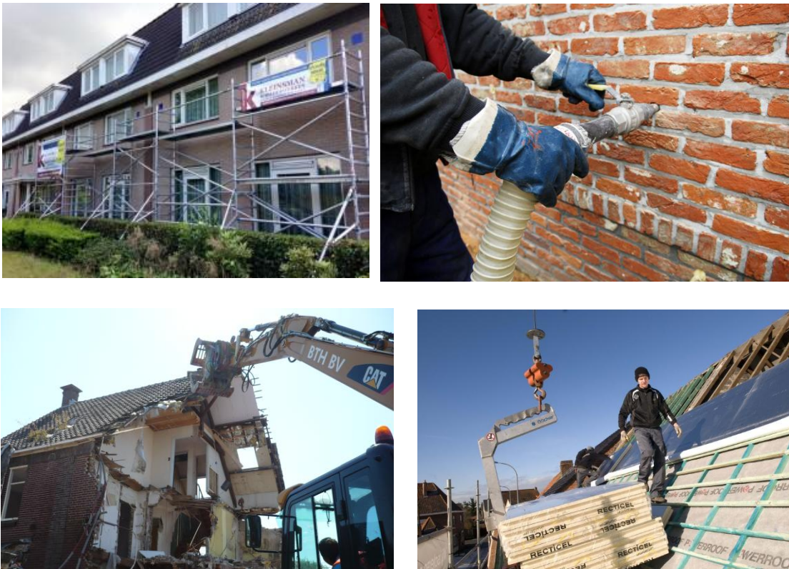
Figuur 30: Voorbeelden (foto's) van veel voorkomende ingrepen bij woningen met schilderwerk, spouwmuur isolatie, sloop en dakisolatie. Deze maatregelen zijn onderdeel van onderhavig SMP.
