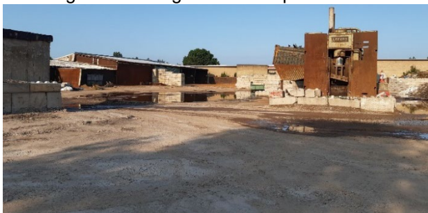
Afbeelding 2.3 Situatie op het zuidoostelijke terrein (Kanaal Zuid 14, Vurec) tijdens het veldwerk, juli 2021
