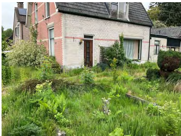
Figuur 8: Overzichtsfoto bebouwing
