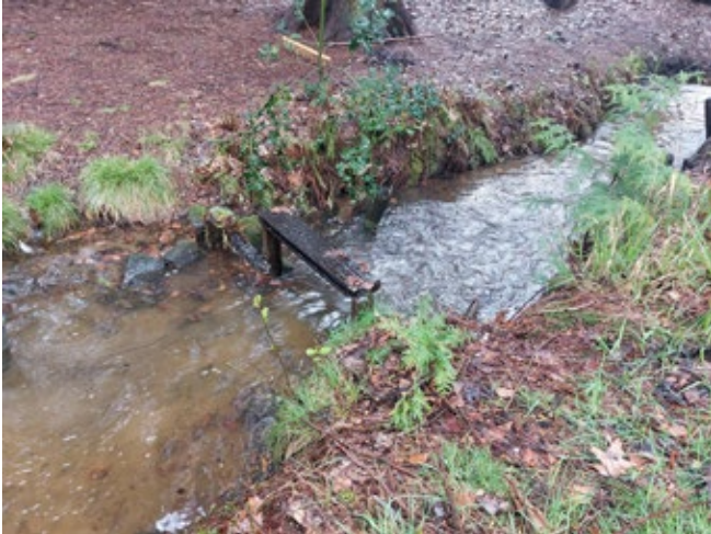
Het waterpeil van de vijver kan gereguleerd worden met een schotbalkstuw. Hierdoor kan water in het gebied vastgehouden worden. .
