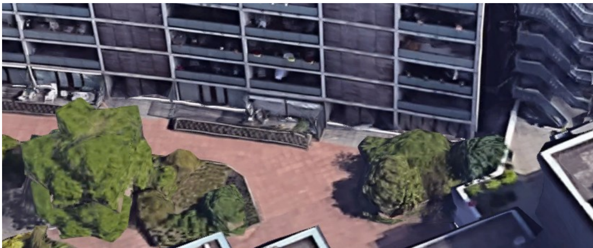
Afbeelding 3.6 Balkons achterzijde Stadskade
