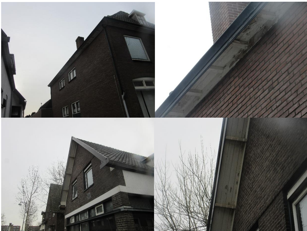
Figuur 4.2 Geschikte openingen voor vleermuizen onder de linkerzijgevel van huisnummer 266 (boven) en onder de voorgevel van huisnummer 268 (onder)
