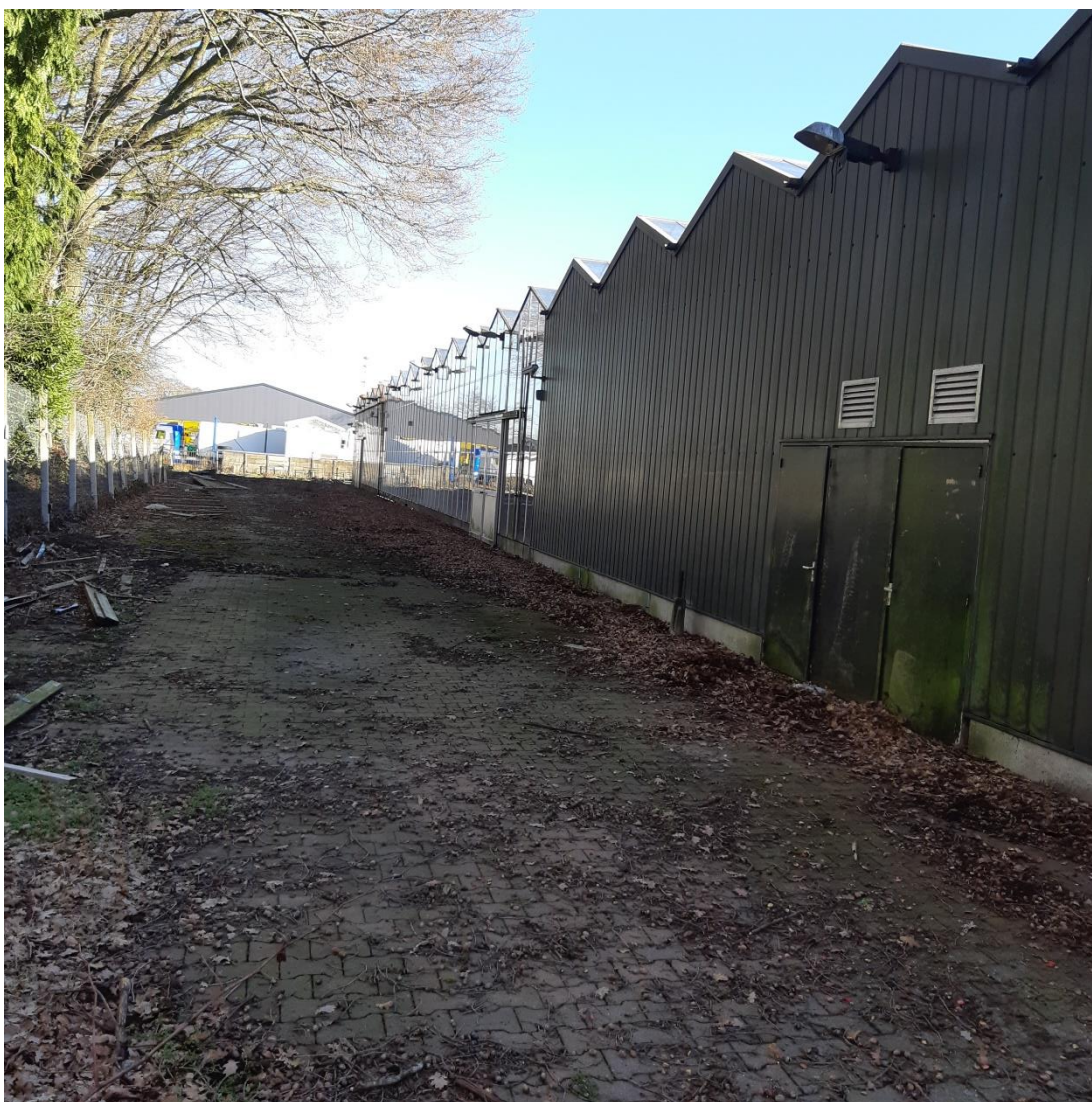
Afbeelding 17: Foto van de achterzijde van de bedrijfshal en kassen van GroenRijk. De foto is genomen ter hoogte van boring 3 in oostelijke richting.
