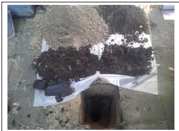
Foto: Inspectiegat A03
