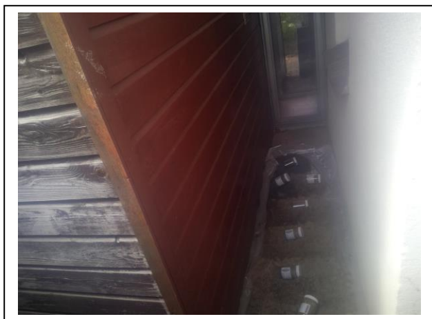
Foto: Inspectiegat B04
