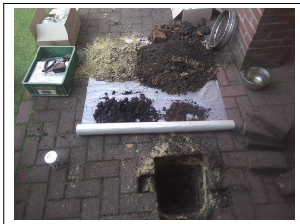
Foto: Inspectiegat A05
