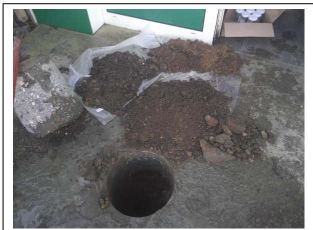
Foto: Inspectiegat B02
