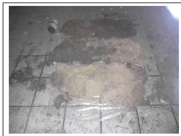
Foto: Inspectieboring B05
