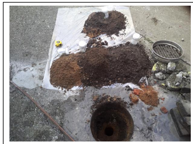
Foto: Inspectiegat B03
