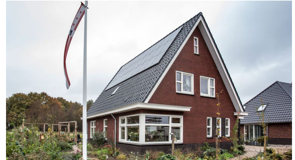
Voorbeeld van een woning die goed past binnen de bestaande woonwijk
