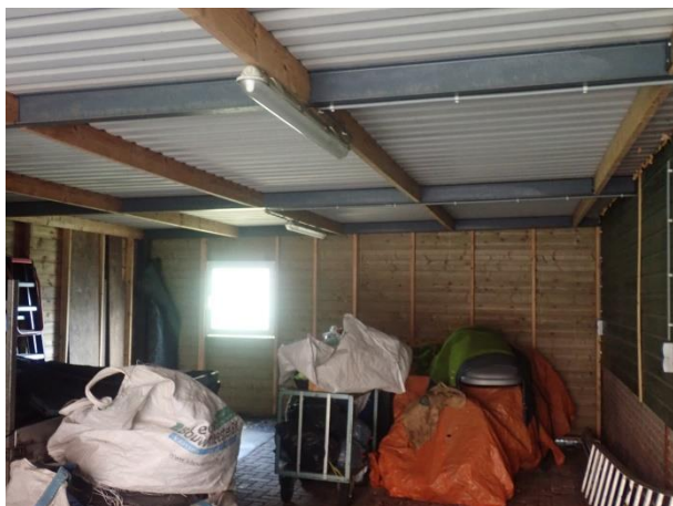
Foto 2: rechts, schuur 1 extern.
