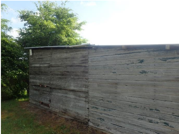
Foto 9: links, schuur 6 extern
