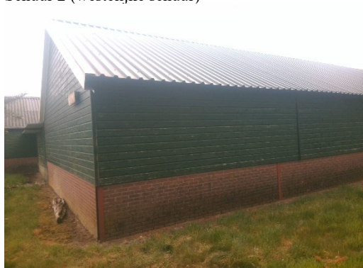
Schuur 2 (westelijke schuur)
