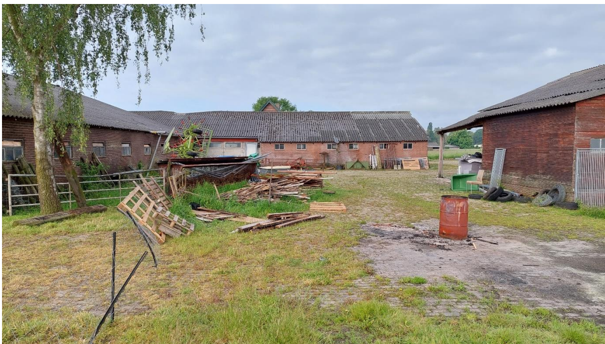
Figuur 15: Plangebied gezien vanaf de noordoostzijde met inkijk tussen de stallen, gefotografeerd richting zuidwesten (bron: KSP Archeologie).
