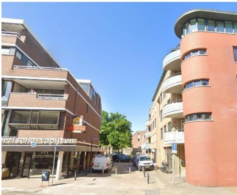
Figuur 2. Bestaande situatie Helfrichstraat, gezien vanaf de Oranjerie.
