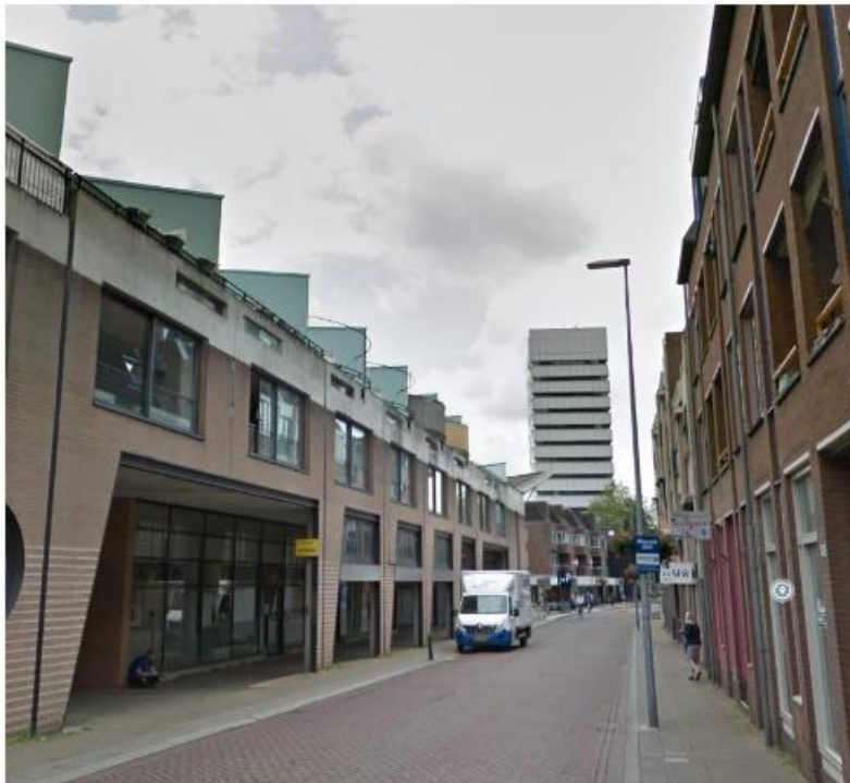
Figuur 1. Bestaande situatie Nieuwstraat met de Oranjerie aan de linkerzijde en het kantoor van het Kadaster op de achtergrond.
