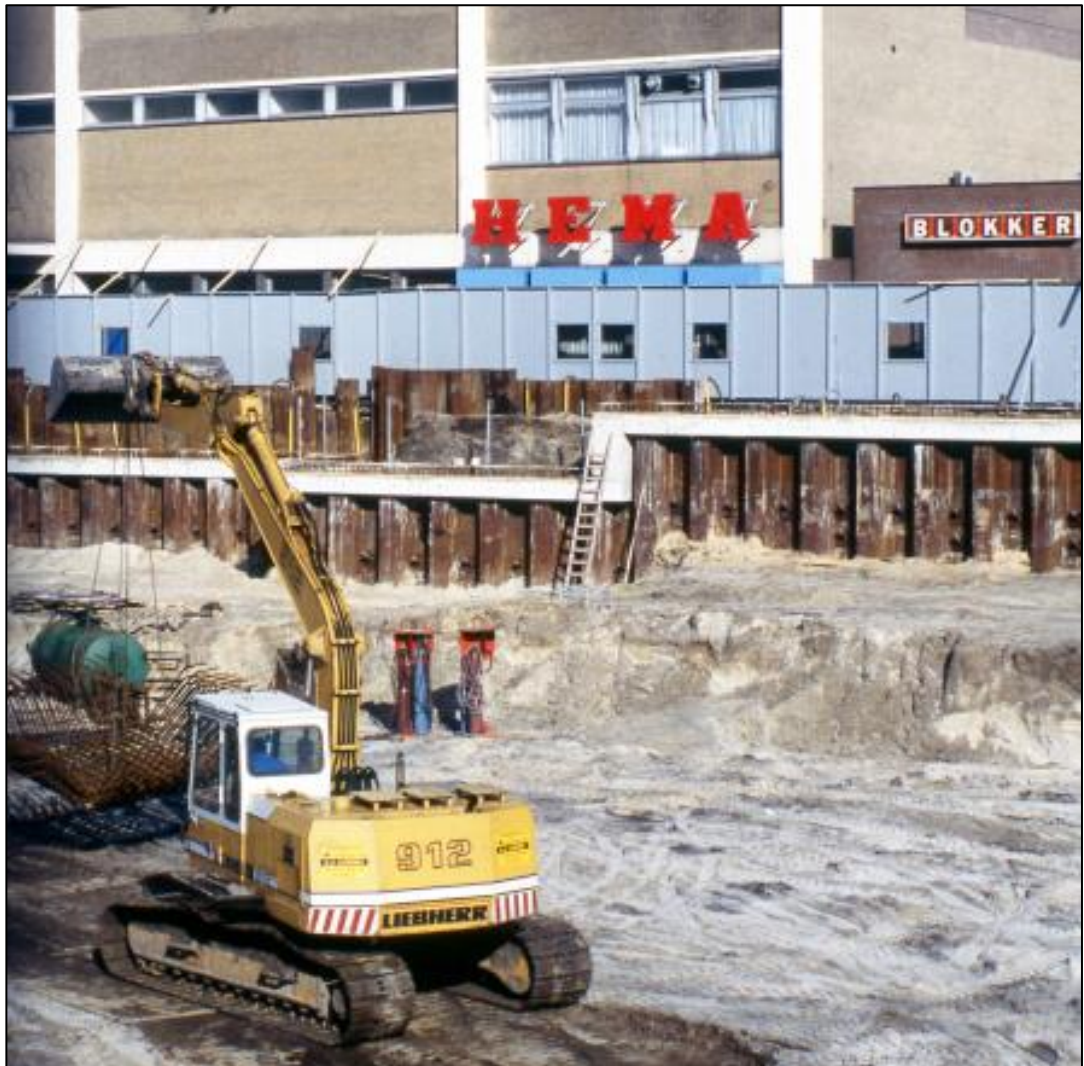
Afbeelding 11. Graafwerkzaamheden tijdens de bouw van het overdekte winkelcentrum de Oranjerie in 1992 (Bron: CODA beeldbank).
