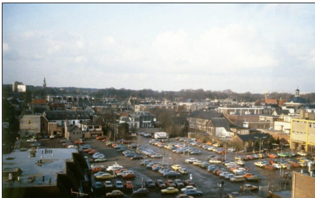
Afbeelding 9. Het plangebied in 1992 in gebruik als parkeerplaats. (Bron: CODA Beeldbank).
