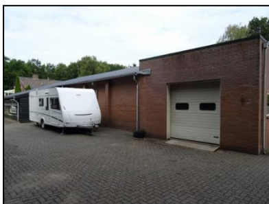
Figuur 6. Ingang garage gezien vanuit de zuidzijde.
