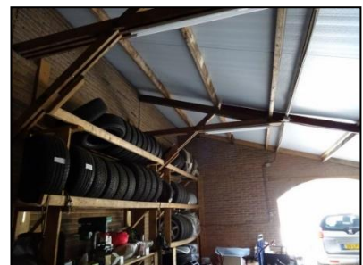
Figuur 8. Binnenkant loods aan de noordkant van de bebouwing.
