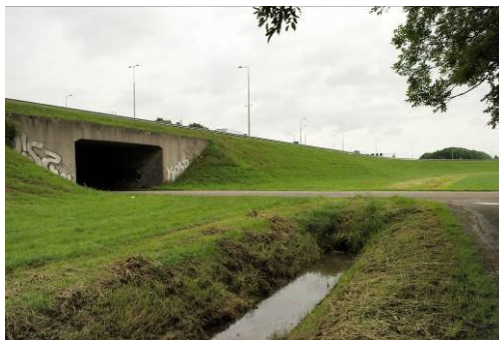
Viaduct onder de A1 ter hoogte van de IJsseldijk.
