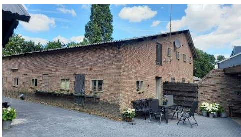
Foto 3a: zuidwestelijk aanzicht te slopen kapschuur
