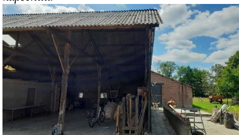
Foto 3c: oostelijke inkijk te slopen kapschuur
