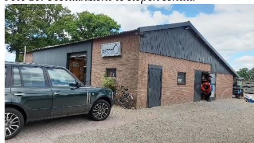
Foto 2d: Zuidoostaanzicht te slopen schuur.
