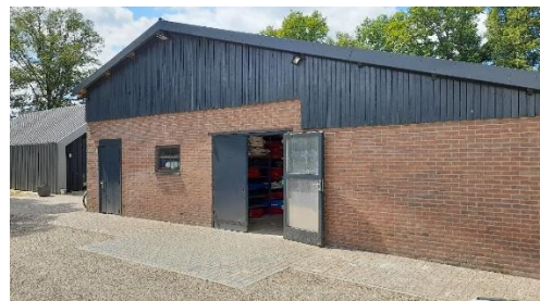
Foto 2b: Oostaanzicht te slopen schuur
