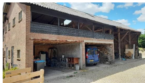
Foto 3b: zuidoostelijke inkijk te slopen kapschuur
