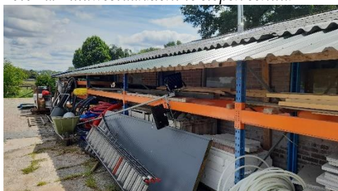
Foto 2c: Noordaanzicht te slopen schuur
