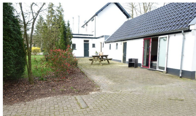
Foto 5 Bestaande receptie en beheerderswoning
