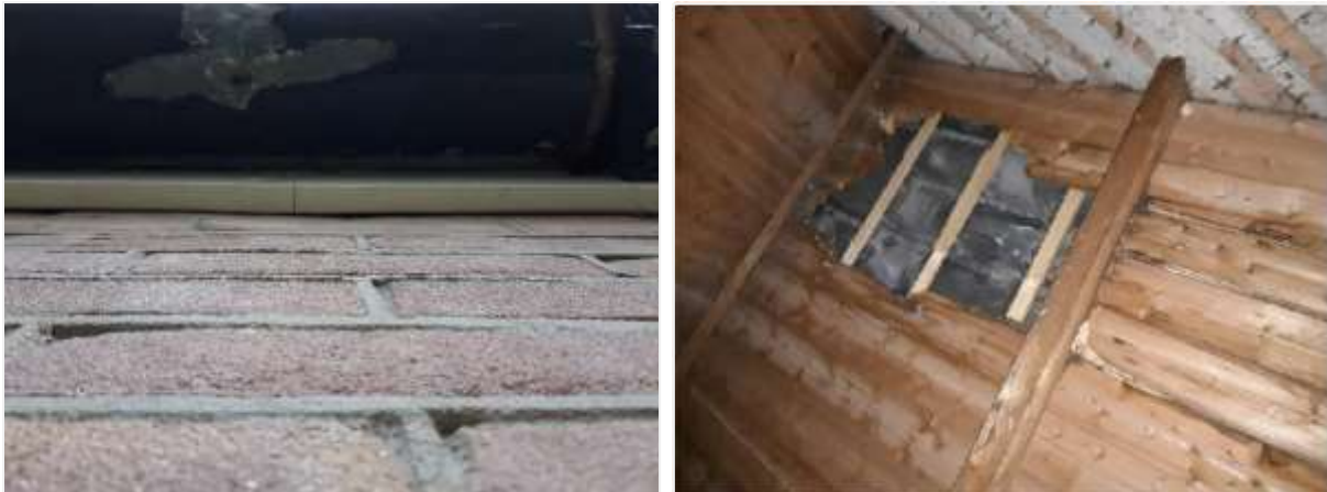
Afbeelding 2: Links: Detail van de daklijst. Rechts: Gat in het dakbeschoot als gevolg van een omgevallen boom. Foto's: Natuurkompas, 2021.
