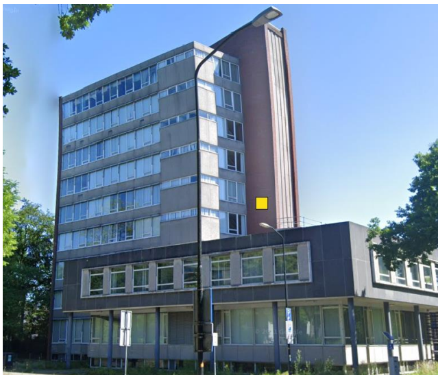
Hangplek van de dubbele inmetzelkraamkast aan de westzijde.
