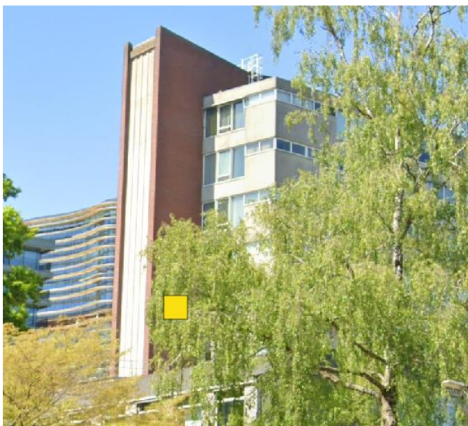
Hangplek van de dubbele inmetzelkraamkast aan de oostzijde.
