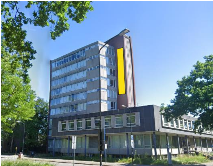
Hangplek van 6 kasten in de westgevel.
