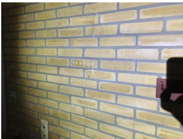
Binnenmuur van de dakopbouw. Hier wordt een extra muur tegenaan gemetseld.
