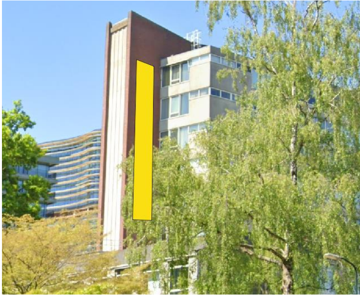
Hangplek van 6 kasten in de oostgevel.
