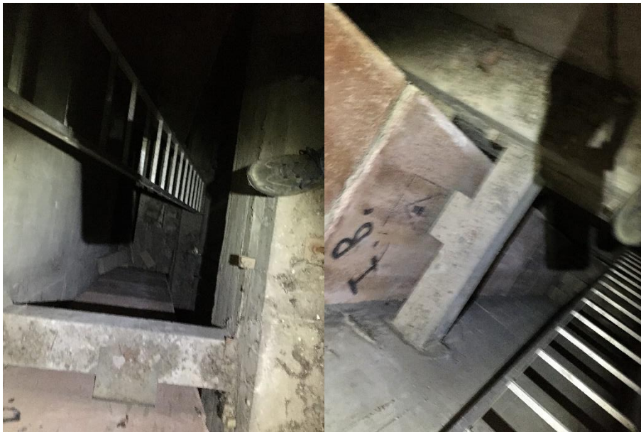
Zicht op de planken in de schoorsteenschacht en schoorsteenschacht.
