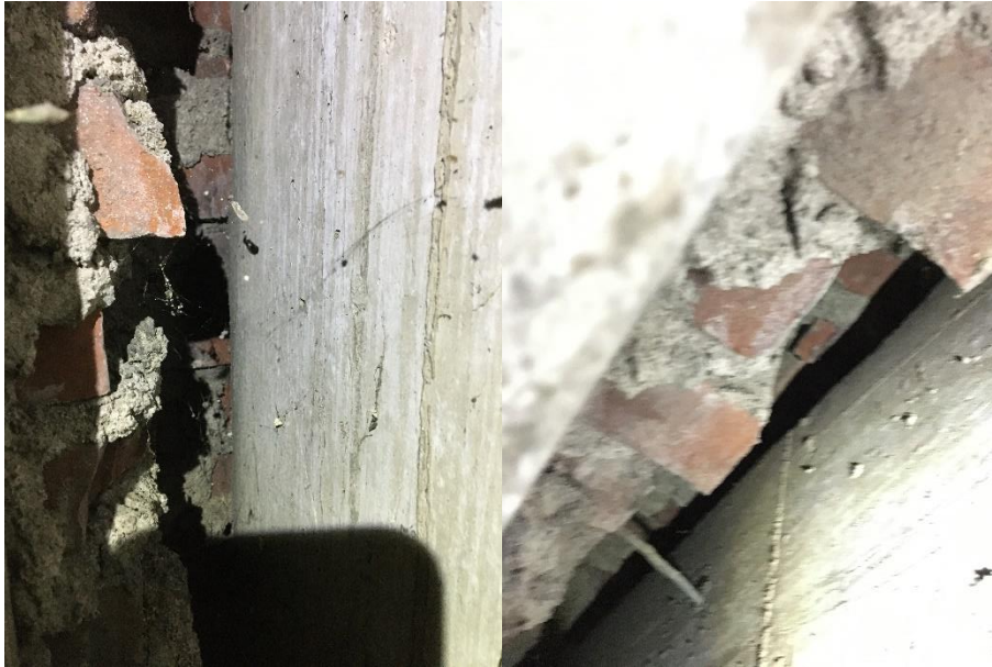
Detailfoto van de binnenzijde. zichtbaar is de betonnen binnenwand en de bakstenen buitengevel.
