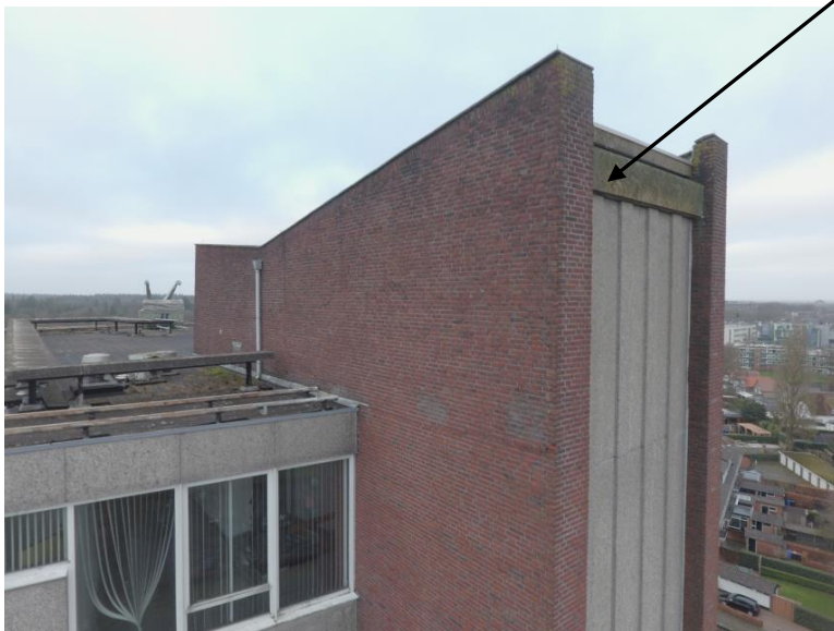
Invliegopening aan de voorzijde van het gebouw.
