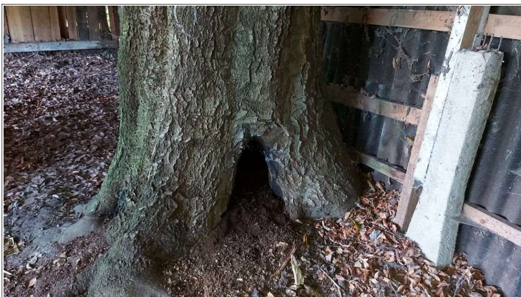
Detail van de zomereik welke in het dak groeit van stal 1. In de boom zijn rottingsholtes aanwezig welke geschikt zijn als potentiële verblijfplaats voor boombewonende vleermuizen. Foto: M. de Vries / Ecoresult B.V.
