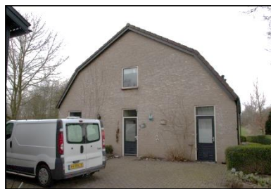
Figuur 4. Gevel zuidzijde woonhuis Kieveen 10.
