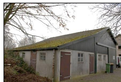
Figuur 5. Oostzijde schuur Kieveen 10.
