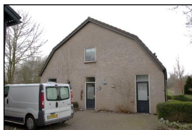
Figuur 4. Gevel zuidzijde woonhuis Kieveen 10.
