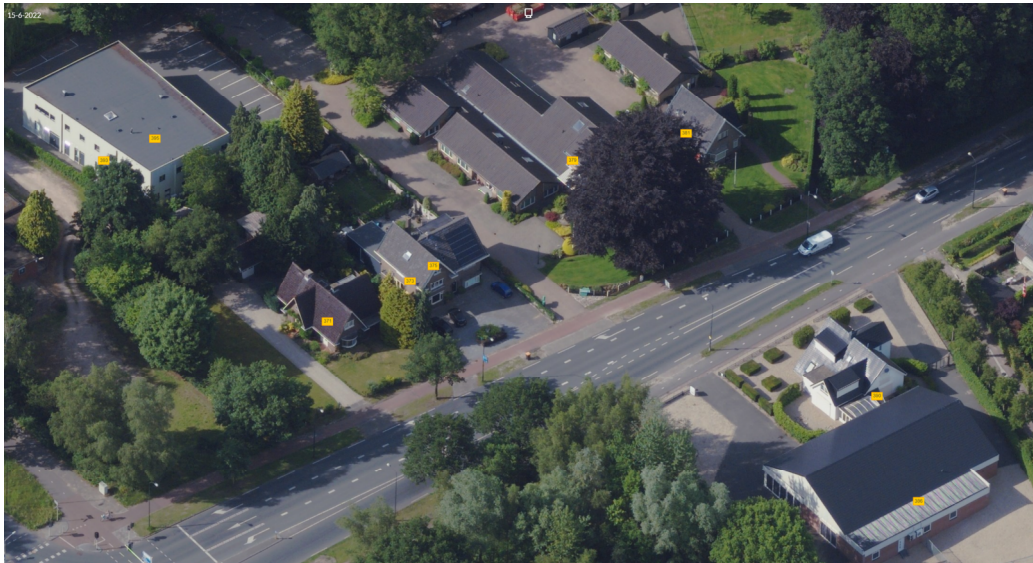
Luchtfoto noordzijde Deventerstraat
