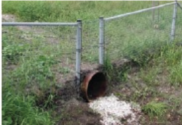
Figuur 17: een goede aansluiting van raster en dassentunnel is noodzakelijk (Bron: Handreiking faunavoorzieningen bij wegen)
