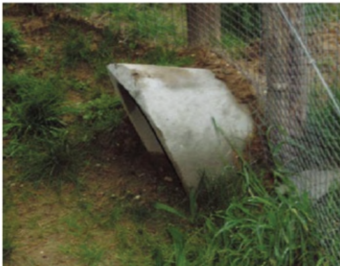
Figuur 18: door het schuine uiteinde zal er minder snel inregenen (bron: Handreiking faunavoorzieningen bij wegen)
