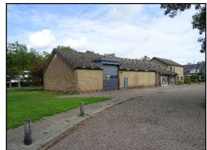
Figuur 8. Zijaanzicht op de loods met aan de rechterkant het woonhuis.
