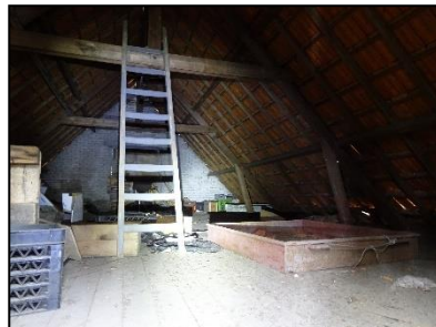
Figuur 4. Open zolder van de schuur. Zadeldak zonder dakbeschot.
