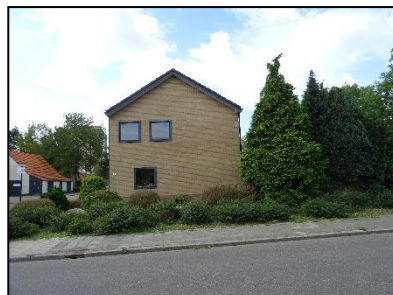
Figuur 7. Vooraanzicht (westelijk) woonhuis met daarachter de loods.
