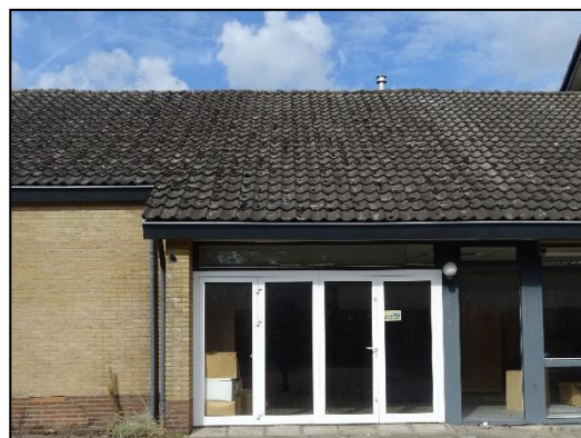
Figuur 10. Ruimte onder dakpannen van de loods.
