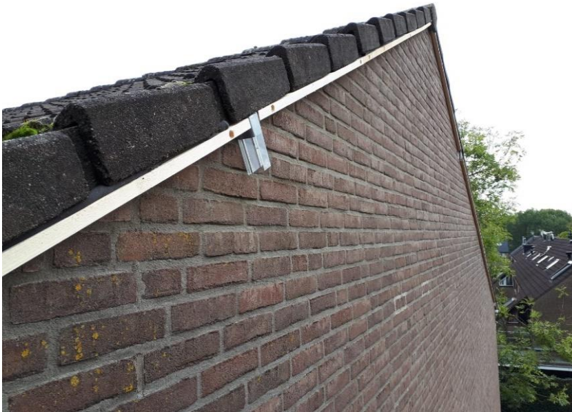
Figuur 8. Twee details exclusion flaps met panlatten en kitrug vulling.
