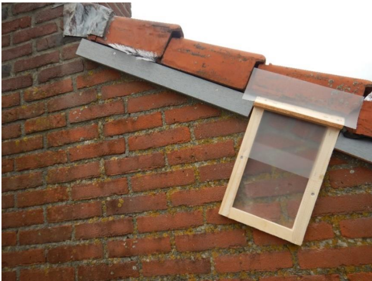
Figuur 7. Detail exclusion flap met dichtzetten gevelpan in combinatie met gootborstels en compriband.
