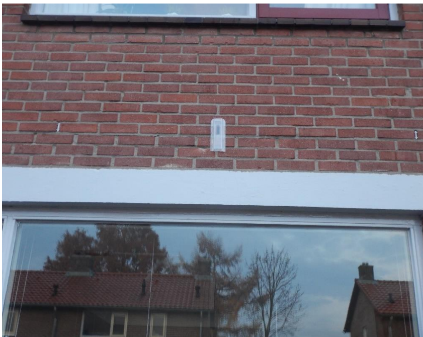
Figuur 9. Detail exclusion flap (midden) en bijenbekjes (links en rechts)
