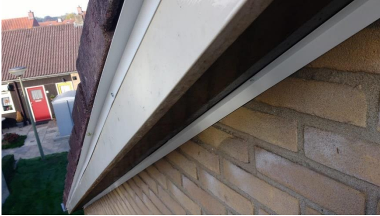
Figuur 6. Hoekprofiel bij kantpannen.
