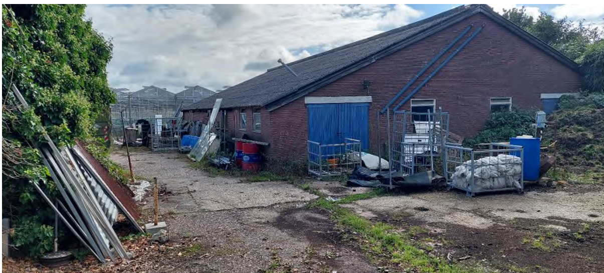
Figuur 18: Grote schuur in de zuidoosthoek, gezien vanaf het westen en gefotografeerd tegen het noorden (bron: KSP).
