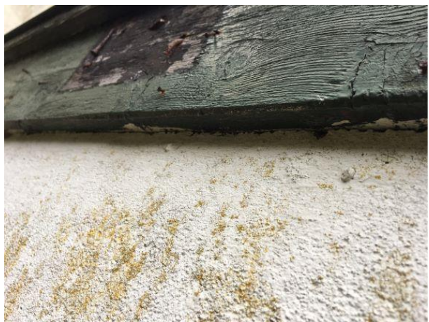
Er zijn geen potentiële invliegopeningen waargenomen op het contactpunt van buitengevel en windveer en betimmering van de overstek.
