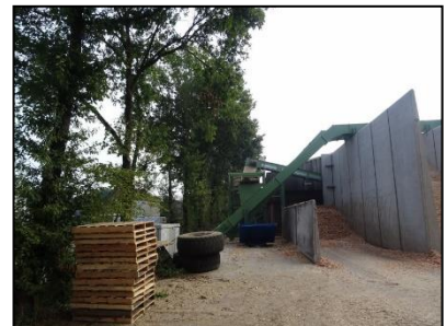
Figuur 5. Achterzijde loods houtzagerij.
