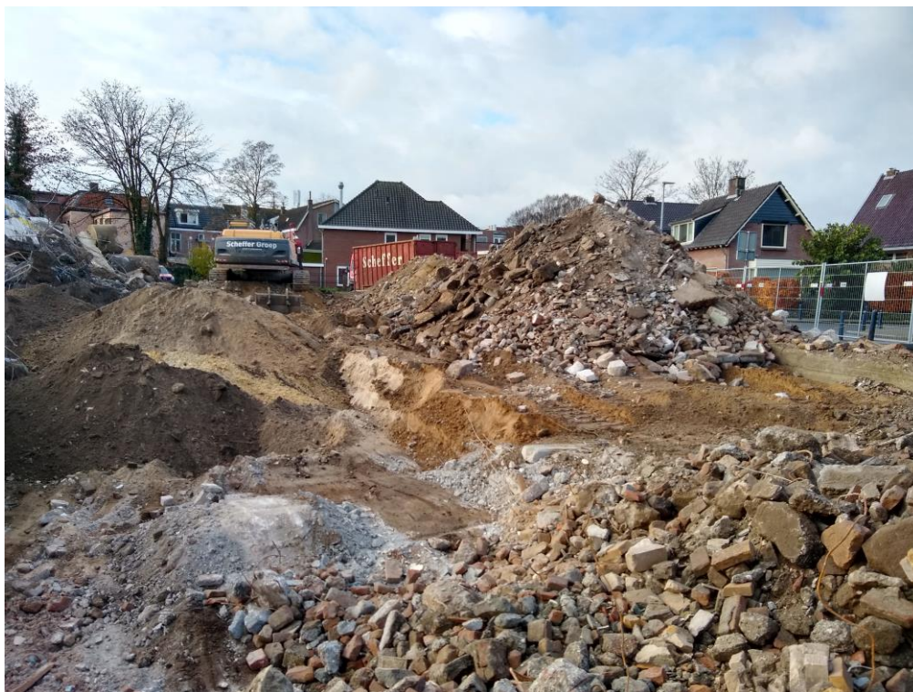
Figuur 4. Impressie van de sloopwerkzaamheden ter hoogte van boring 3. Blik richting het zuidwesten. Op de voorgrond is een betonnen funderingspaal zichtbaar.
