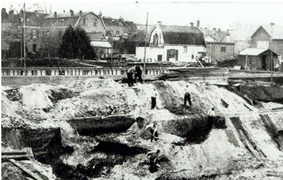
Figuur 5. Aanleg van het Sportfondsenbad in 1934. Het voormalige bad werd met de hand in getrapt talud uitgegraven. Bron: Beeldbank CODA Apeldoorn.
