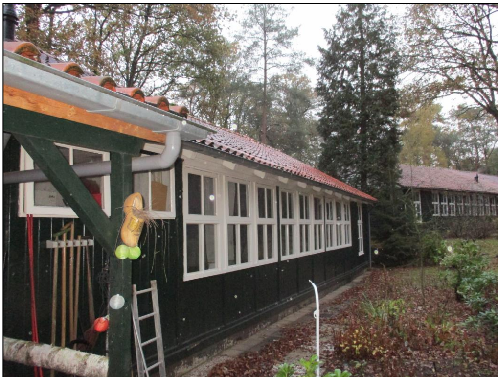
Figuur 2 In de zuidkant van de planlocatie zijn meerdere barakken gelegen met houten wanden en zadeldaken met dakpannen.
