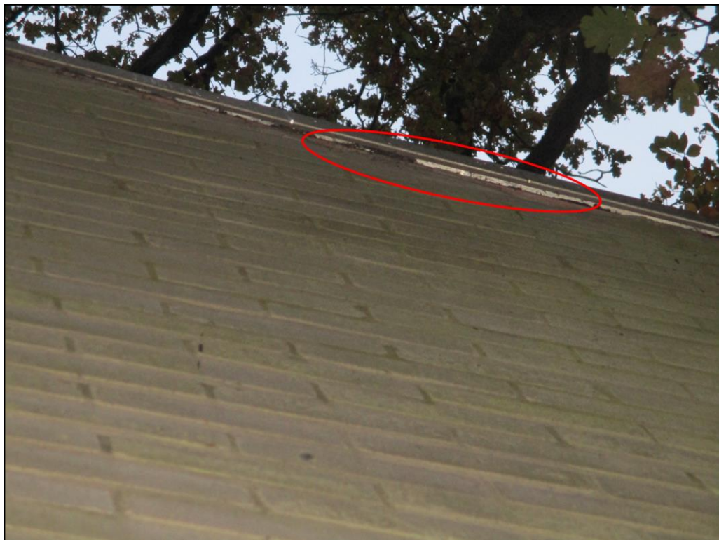
Figuur 4 De kapel (A) bevat kierende daklijsten, waardoor vleermuizen hier een geschikte verblijfplaats kunnen aantreffen.
