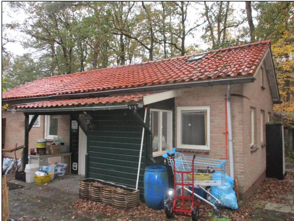
Figuur 3 Gebouwen C, E, F, G, H, I (afgebeeld) en J bevatten pannendaken welke toegankelijk zijn voor huismussen.
