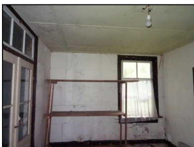
Figuur 6. Binnenzijde woning 't Schot.
