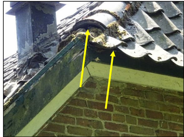
Figuur 10. Ruimtes bij dakpannen.
